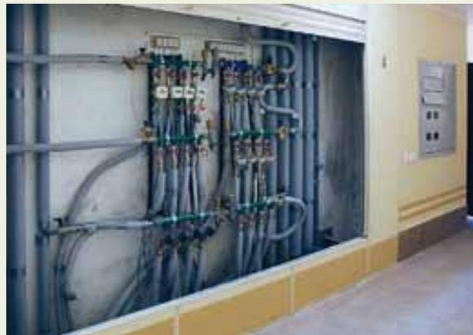
дую квартиру проходит несколько отопительных стояков. Поквартирный учет тепла осуществляется при помощи радиаторных счетчиков, для этого их устанавливают на каждом отопительном приборе в квартире, а дом должен быть оборудован общедомовым прибором учета тепла.
